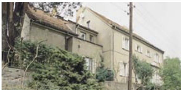
Die umfassenden Renovierungsarbeiten der Siedlung dauern an. Erschwerend kommt hinzu, dass kein Farbplan Tauts vorliegt.
