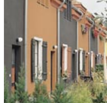
Die Strenge von Reihenbebauungen löst Taut mit Farbkontrasten auf und erreicht so eine lebendige Atmosphäre.
