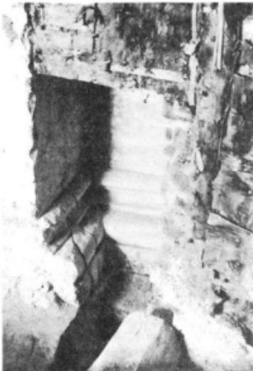
ваются старые очень серьезные повреждения, целая сеть широких трещин, выбалы кладки и т. п. Места таких зондажей должны определяться архитектором совместно с инженером, поскольку они могут дать информацию, важную и для инженерно-технического, и для архитектурного исследования.
