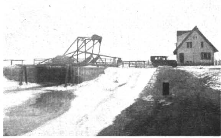
Abb. 2. Schleuse Schwägerau vom Unterwasser aus.
