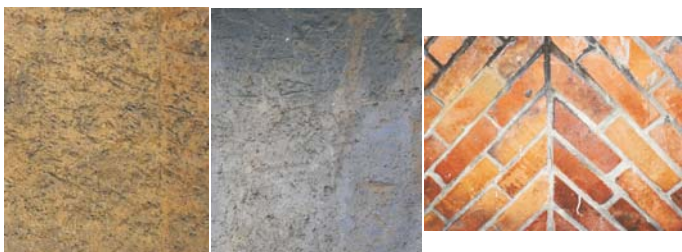
Штукатурка и декоративная кирпичная кладка
