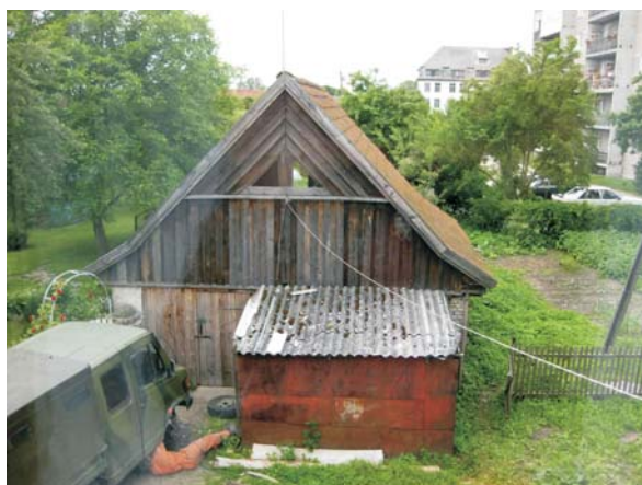
Хозяйственные постройки для каждой квартиры
