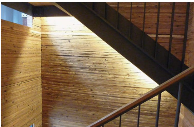
Die Treppenkonstruktion aus Stahl wurde direkt in eine der Silozellen integriert. So weit wie möglich blieben die Brettstapelsilowände sichtbar.
