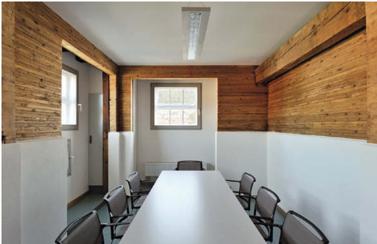
Der Besprechungsraum befindet sich in einer der ehemaligen Silozellen, deren Brettstapelwände erhalten blieben. Lediglich im unteren Bereich sind die Innenwände verputzt.
