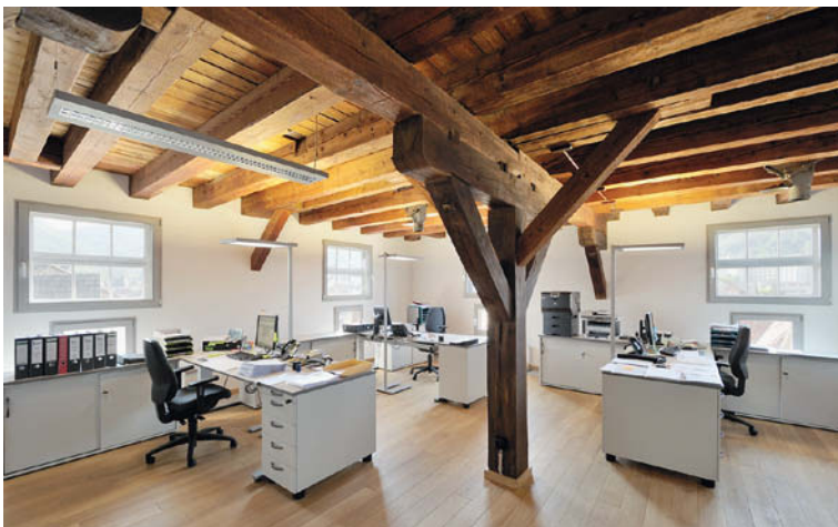
Im südlichen Gebäudeteil ist der originale Bretterboden aus Fichte als Deckenunterseite erhalten.
