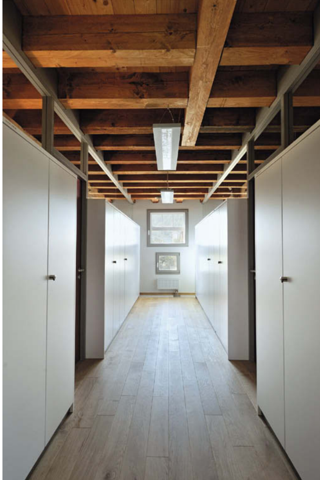
Als funktionale Trennwände zwischen den Büros wurden Schrankwände eingezogen.
